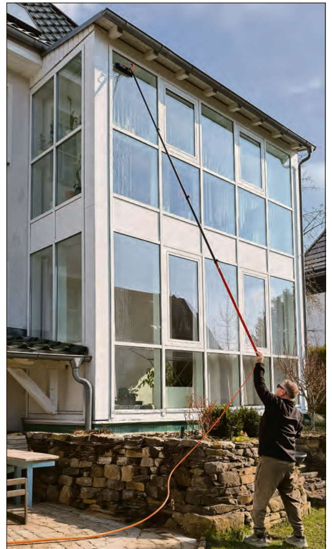
Malermeister Mike Ludwig bei der schonenden und streifenfreien Reinigung eines Wintergartens mit moderner Osmose-technik – ganz ohne Gerüst.
