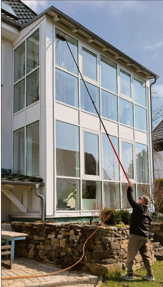
Malermeister Mike Ludwig bei der schonenden und streifenfreien Reinigung eines Wintergartens mit moderner Osmose-technik – ganz ohne Gerüst.
