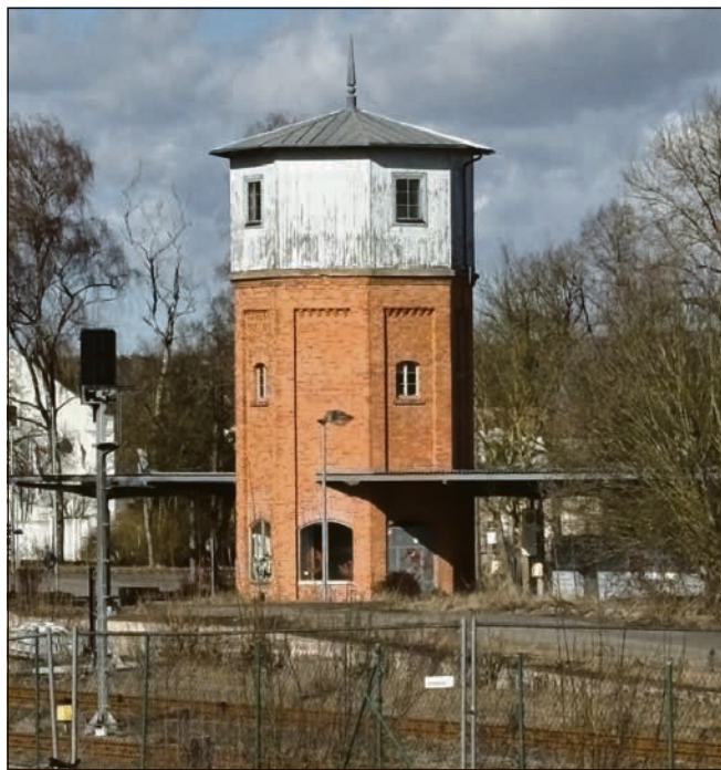
Der Wasserturm in Hildburghausen soll saniert werden – geplant als Mobilitätszentrum für den öffentlichen Personennahverkehr. Die Stadt veranschlagt dafür 200.000 Euro, obwohl eigentlich der Landkreis zuständig ist.
