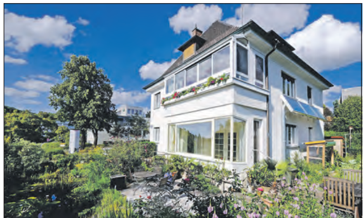
Eine Solarlüftung an der Südfassade sorgt jetzt für ein besseres Raumklima im Keller. Foto: djd-k/GRAMMER Solar GmbH
