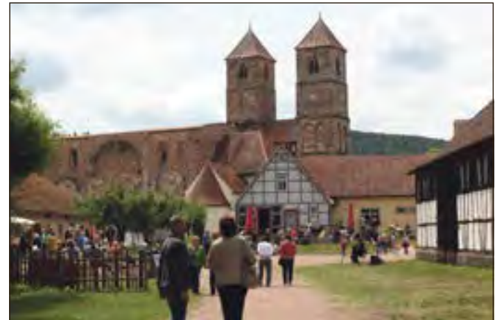
Blick auf die Klostertürme aus östlicher Richtung.
