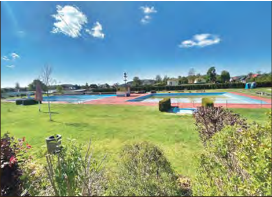
Die SPD-Fraktion will an dem Ursprungskonzept der Freibadsanierung festhalten.
