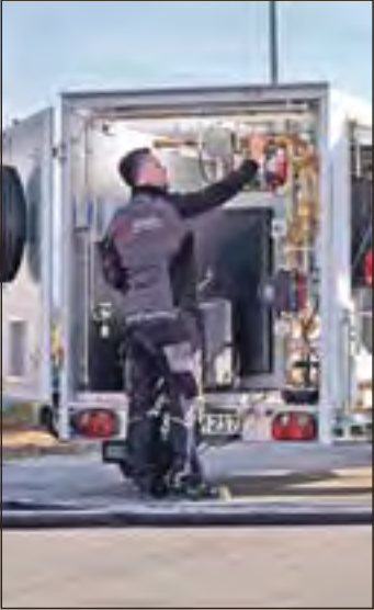
Die Zeit bis zur endgültigen Heizungsreparatur kann man beispielsweise mit einer Mietheizung überbrücken.
