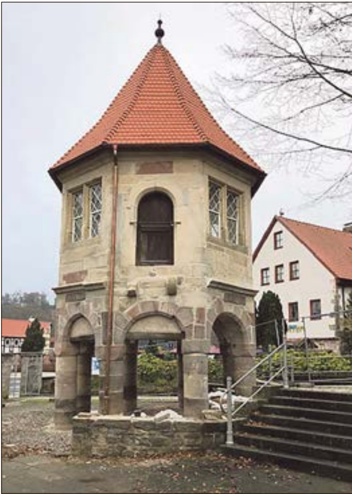
Brunnenhaus mit restaurierten Fassaden und saniertem Dach. Foto: Stiftung Thüringer Schlösser und Gärten, Katja Hanf
